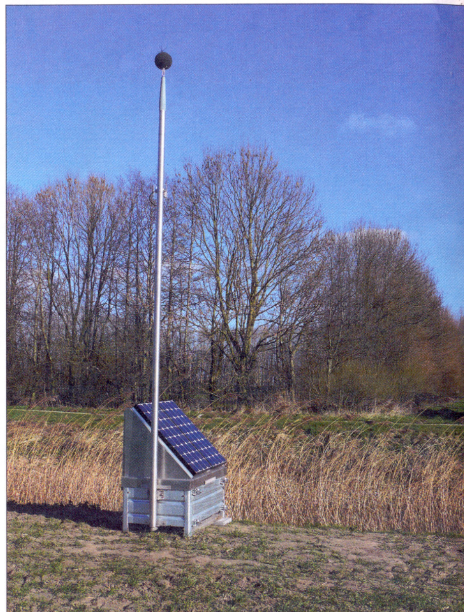
Automatisch geluidmeetstation van DGMR op zonnecellen
