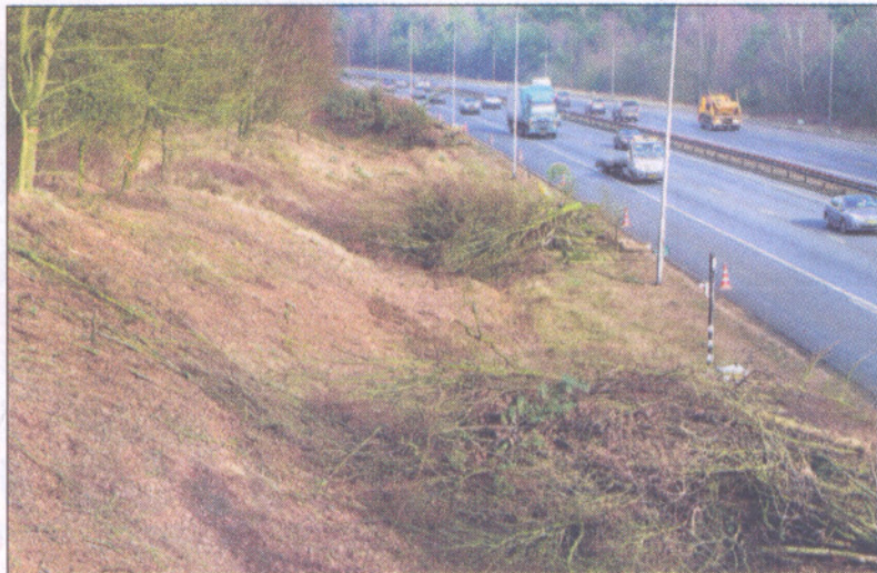
De voorbereidende werkzaamheden zijn begonnen. foto De Gelderlander
